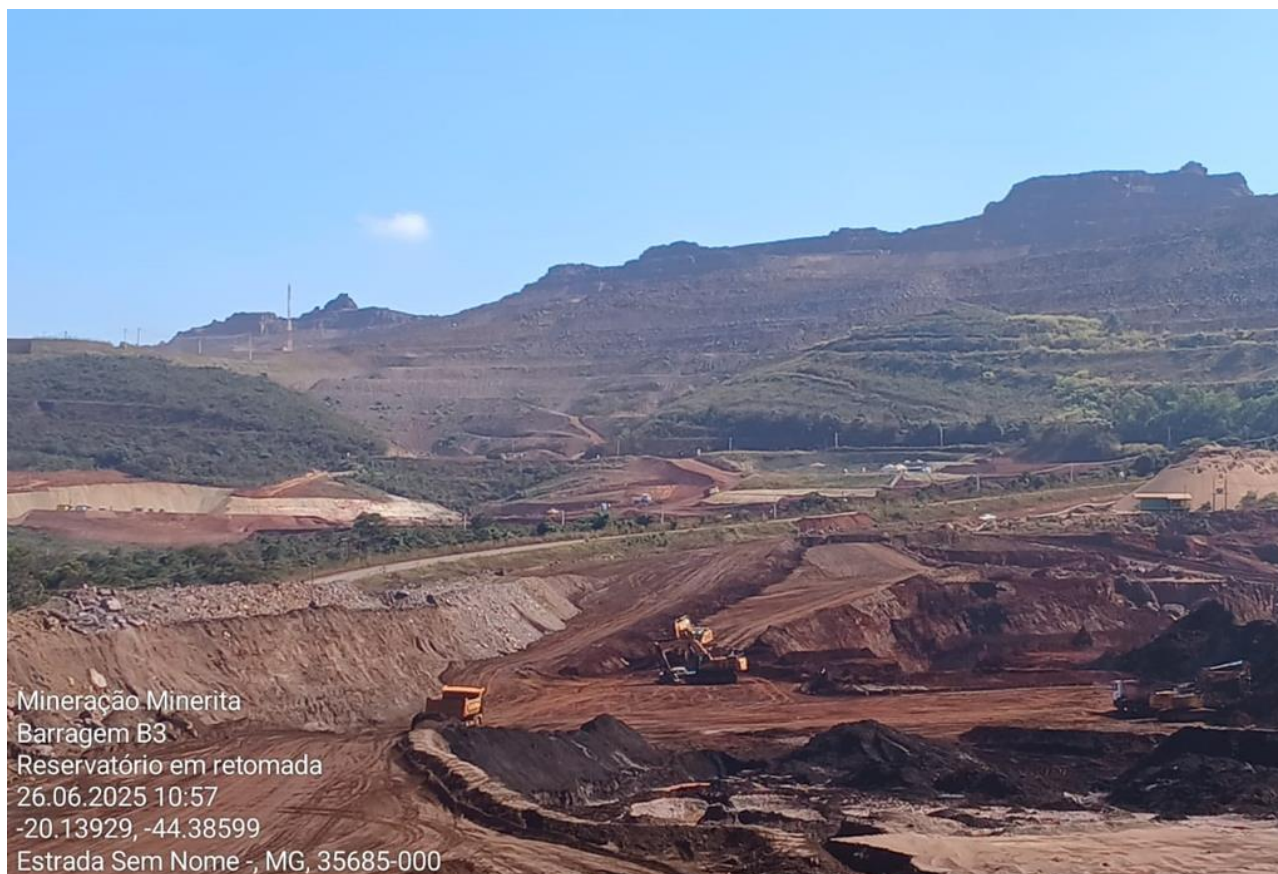
Escavação realizada por conjuntos escavadeiras e caminhões basculantes.
